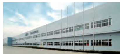
General Central Air-conditioner (Уси) Co., Ltd. (Китай)
